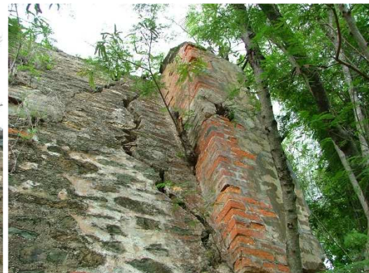
Photos ci-dessus : à gauche, détail mur pignon ; à droite, détail désordre mur de soutènement.
