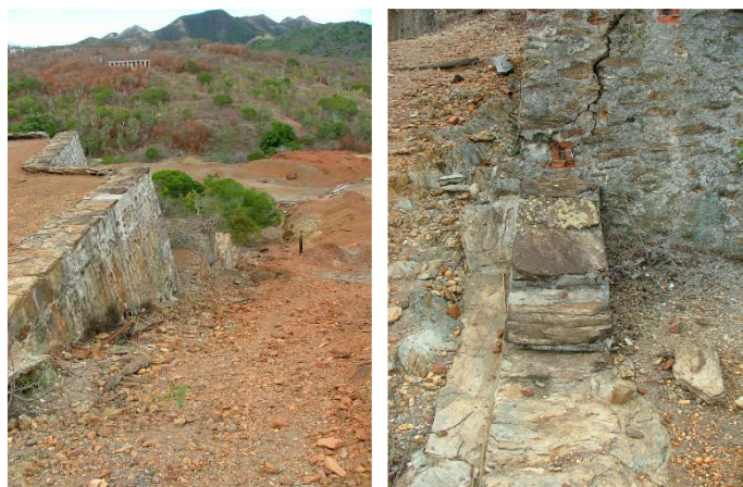
Photos ci-dessus : à gauche, détail mur de soutènement côté nord ; à droite, détail désordre mur de soutènement. Ce niveau dessert plusieurs vestiges dispersés, parmi lesquels se trouve la grande cheminée bien visible sur les documents d'époque. La base de cette structure, qui s'enfonce de plusieurs mètres dans le sol, reste accessible mais présente un danger manifeste. On peut en effet distinguer, au fond de l'ouvrage, des ossements d'animaux ayant chuté accidentellement dans la cheminée.
